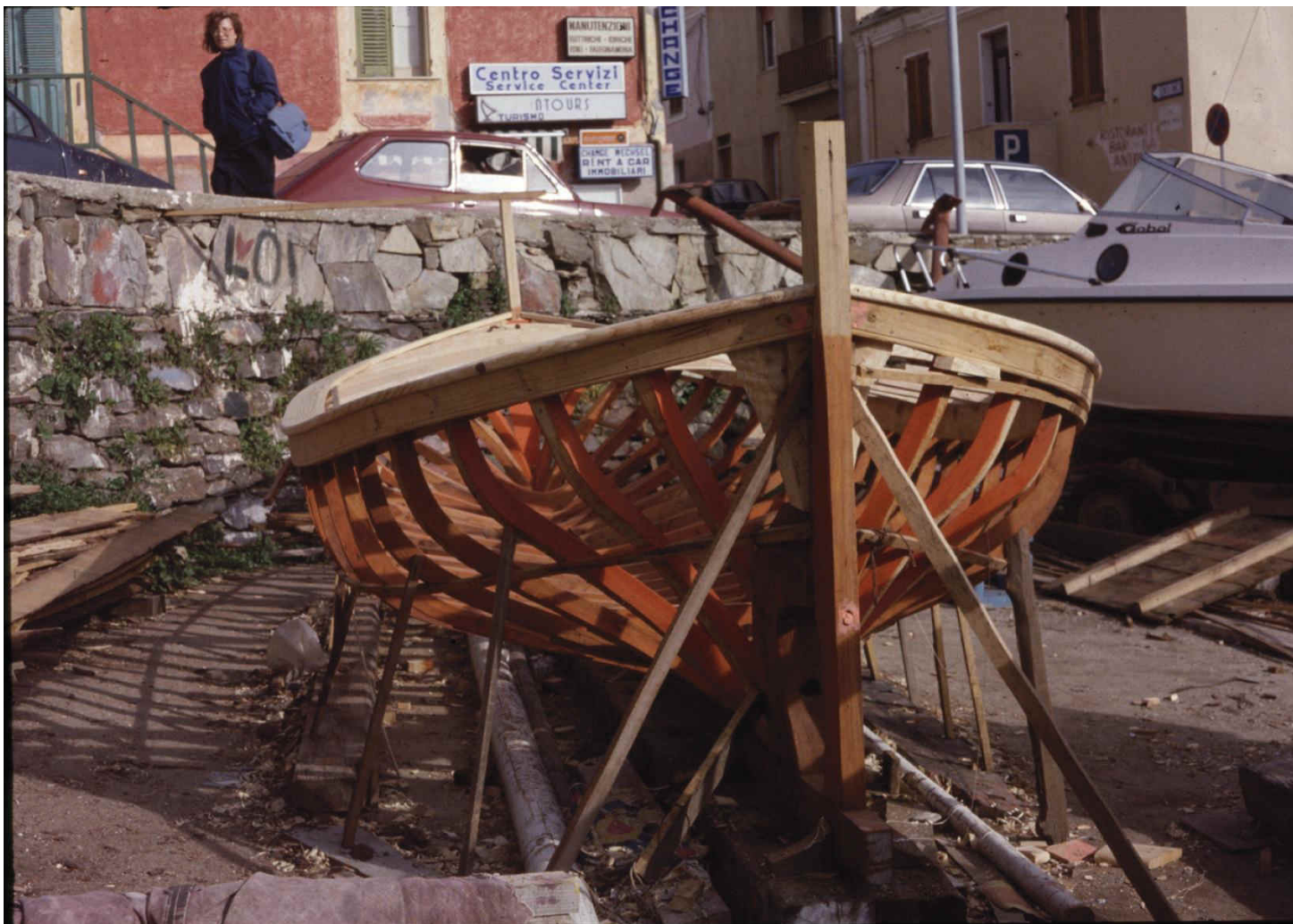
Cantiere al Porto Vecchio, con antropologa che osserva
